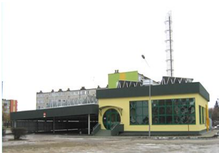
Fot.18.Kotłownia gazowa na os. Unii Lubelskiej
