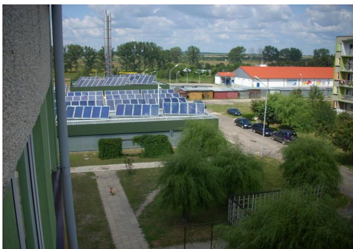
Fot.19.Kolektory słoneczne na kotłowni gazowej os.Unii Lubelskiej
