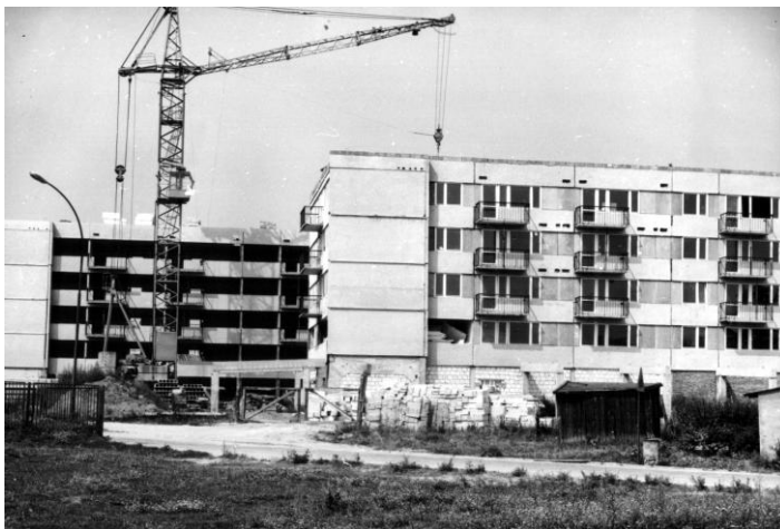
Fot.10. Budynki Nr 3b i 3c na os. Unii Lubelskiej w budowie
