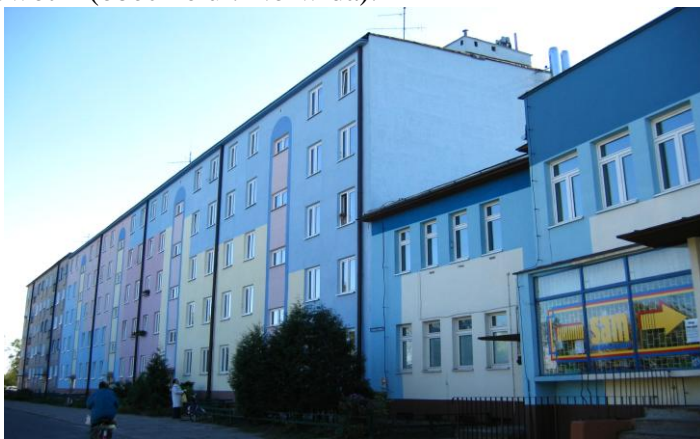
Fot.3 Budynek nr 4 przy ul. Norwida
