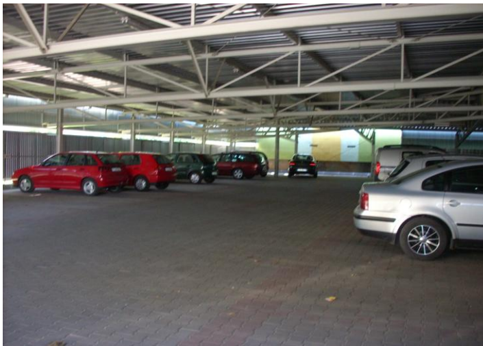
Fot.17. Garaż wielostanowiskowy przy kotłowni gazowej na os. Unii Lubelskiej
