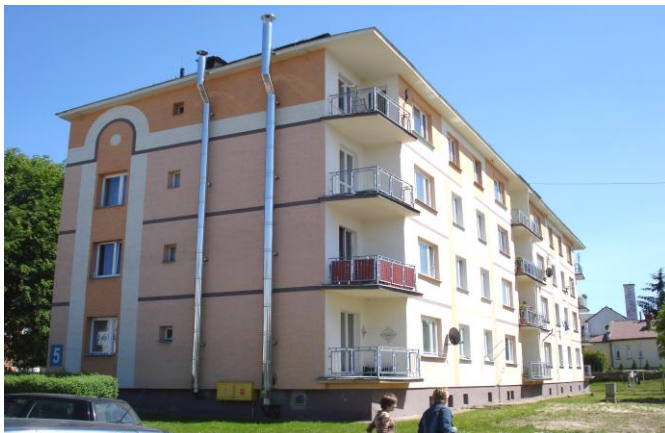
Fot.1 Budynek nr 5 przy ul. Legionów
