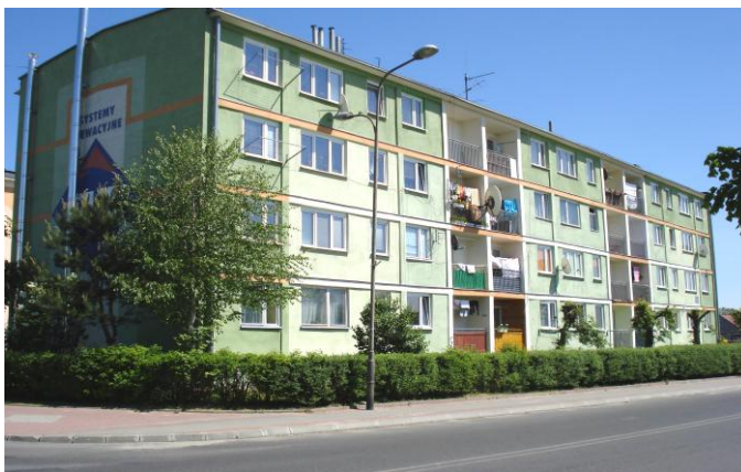
Fot.2 Budynek nr 7 przy ul. Legionów
