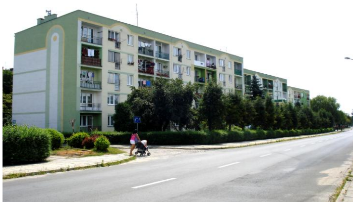
Fot.4. Budynek nr 24, 26, 28 przy ul. Słowackiego
