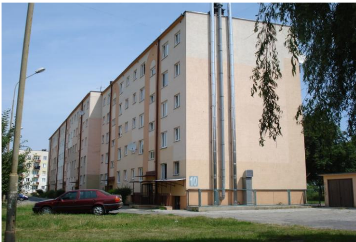
Fot.6. Budynek nr 10 przy ul. Norwida
