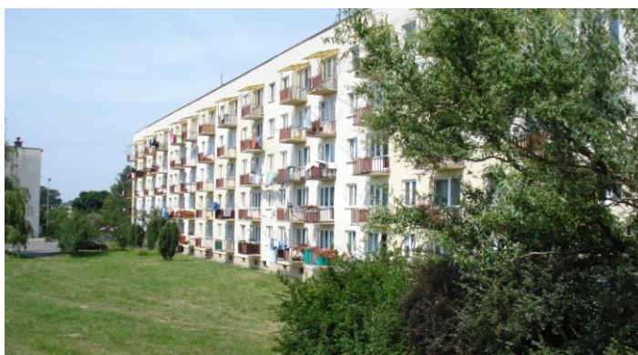
Fot.5. Budynek nr 8 przy ul. Norwida
