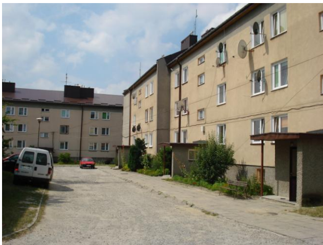
Fot.45.Blok Nr 2 (po lewej) i 3 (w głębi) os. Kustronia
