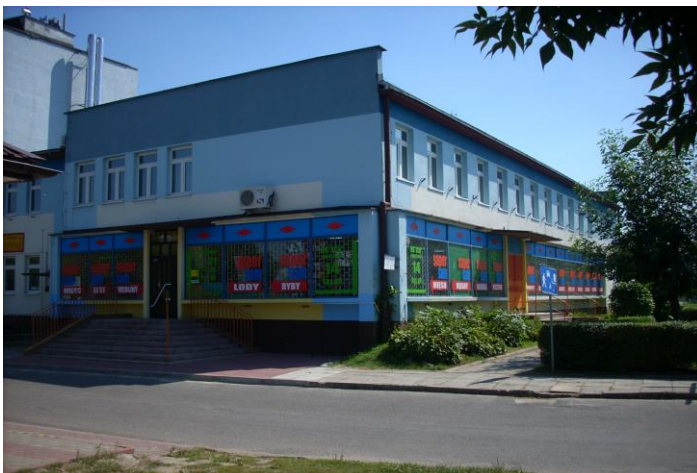
Fot.7. Budynek biurowy z częścią handlową w parterze przy ul. Norwida
